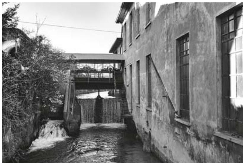
Dopo la prima guerra mondiale, nel frattempo i fratelli Turck erano subentrati alle precedenti gestioni, il complesso venne interamente ristrutturato, con la ricostruzione dei solai in cemento armato e l'impiego di turbine idroelettriche al posto di quelle idrauliche. Nel 1929/30 i fratelli Turck rilevarono completamente la proprietà dello stabilimento.
